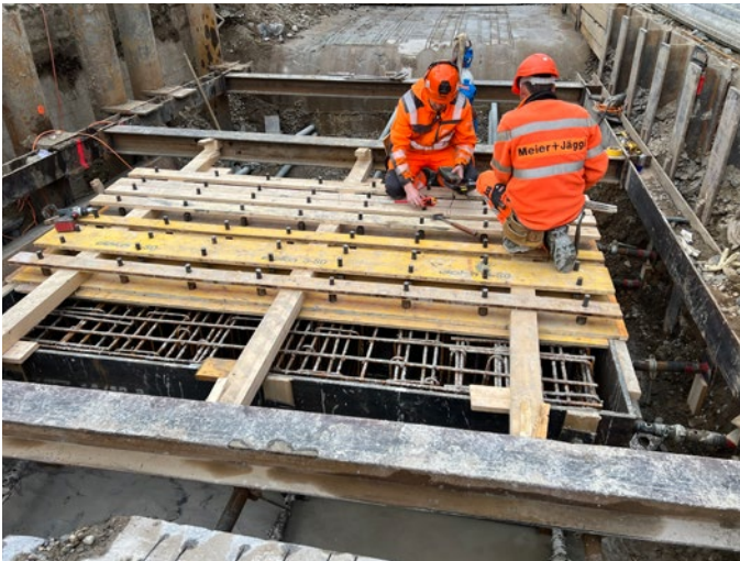
Abb. 5: Vermessung Ankerbolzen im Mittelaufleger
