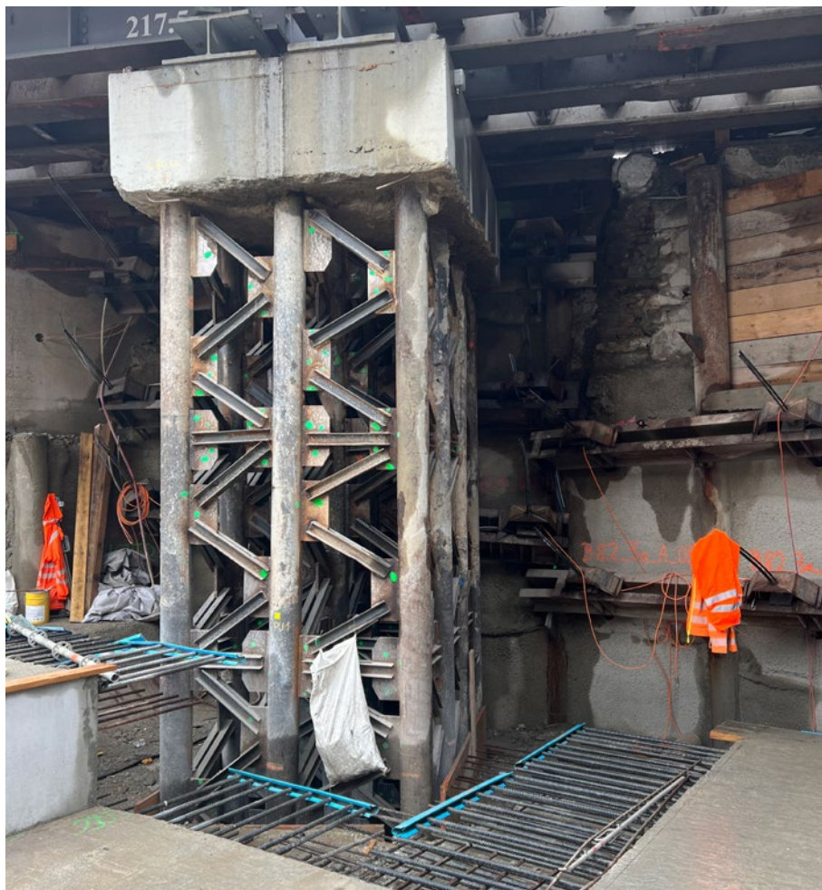
Abb. 4: Mikropfähle mit Fachwerk Mittelaufleger
