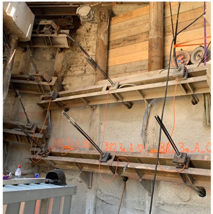
Abb. 8: Rühlwandträger gesichert mit Vorspannanker
