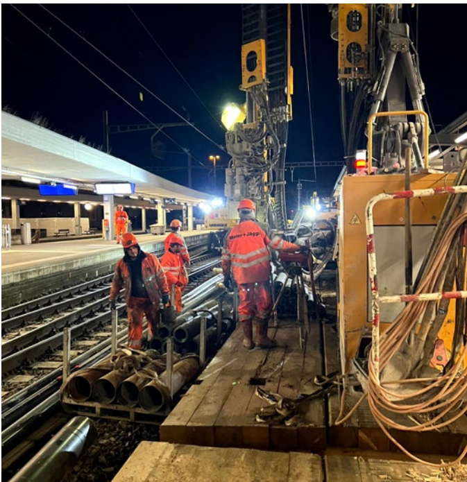
Abb. 7: Erstellung Rühlwandträger in der Nachtspernung
